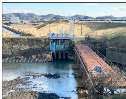
吉田川と鶴田川を立体交差させ、高城川に排水するための吉田川サイフォンをガイド。
