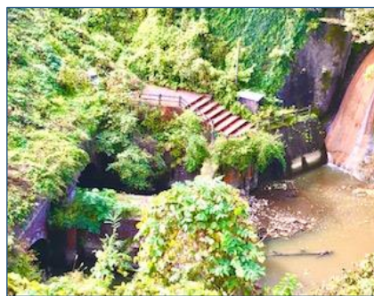
品井沼干拓の遺構「高城川トンネル（明治潜穴）」。品井沼の水を松島湾に抜くための排水路です。
